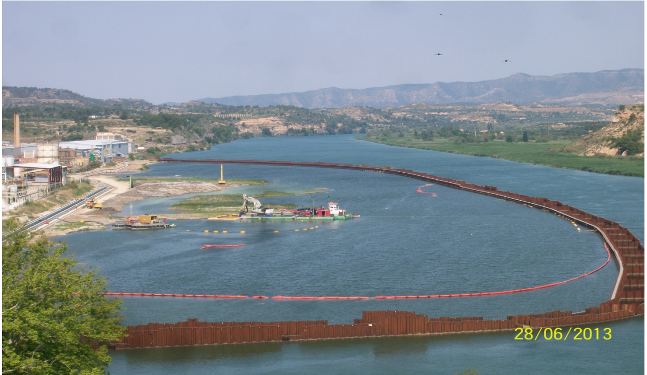
Activités de dragage à l'intérieur du champ de palplanches
